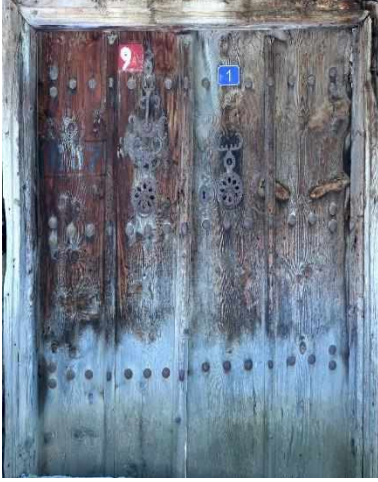
Fotoğraf 5. Yukarı (Ulya) Arika Mah. 1 No'lu ev, Cavit Karaman Evi (İsakgil'in Ev) kapısı
