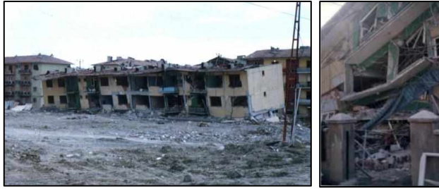
Resim 1. 1992 depremi sonrası Fatih mahallesinde hasar alan binalar
