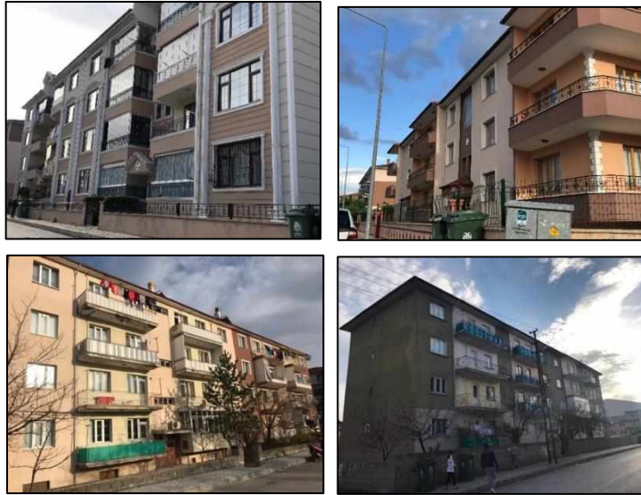
Resim 2. Çalışma alanındaki örnek betonarme binalar
