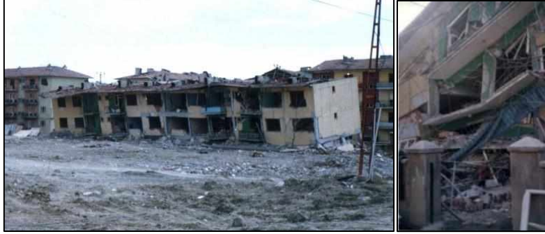
Resim 1. 1992 depremi sonrası Fatih mahallesinde hasar alan binalar
